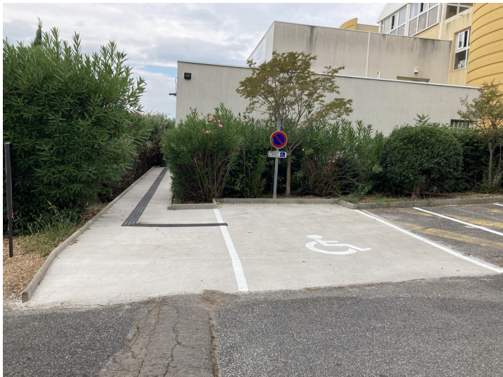
Place PMR bas : marquage horizontal et vertical et mise en place de la bande de guidage
