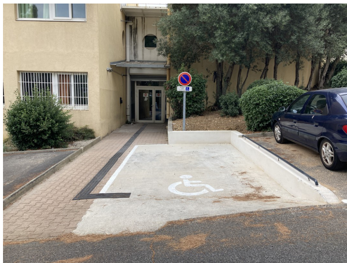
Place PMR haut : marquage horizontal et vertical et mise en place de la bande de guidage
